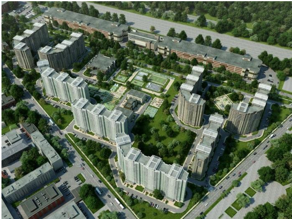
Рис.2 ЖК «Большое Кусково» (г. Москва, Перовская ул.)
