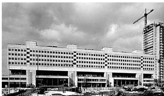
Рис.6 Строительство первых корпусов МИСИ на Ярославском шоссе
