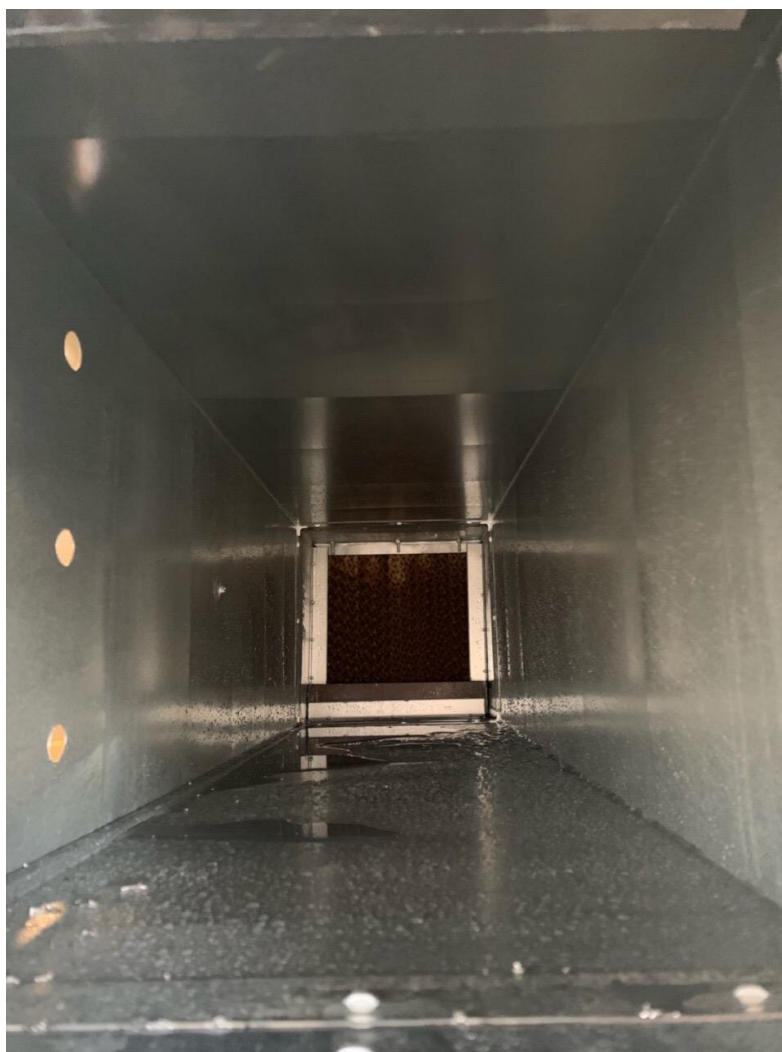
Рисунок 3.3 - Унос влаги из сотового увлажнителя
