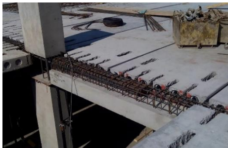
Рис.1 Конструкция стыка ЖБ элементов
