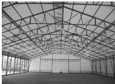
Рис. 1. Стержневые конструкции: а) Металлические железнодорожные мосты, б) Ангар
