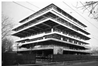
Рис. 2. Адм. здание в г. Москва на ул. Шарикоподшипниковская. Консольные вылеты балок до 9 м
