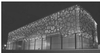
Подстанция Роза Хутор
