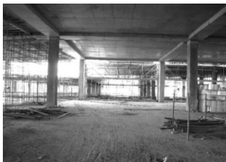
Рис. 1. ТРК «РИО», г. Москва Перекрытия преднапряженные пролетом 12x12 м
