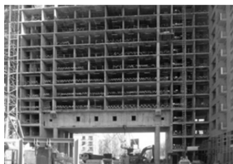
Рис. 4. ЖК «Велтон Парк», г. Москва Преднапряженная балка-стенка пролетом 24 м
