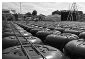
Рис.1. Фрагмент перекрытия с пустотообразователями «Cobiax»
